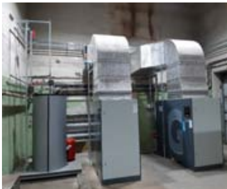
Dva nové kompresory s akumulací nádobou a potrubní trasa do budov
