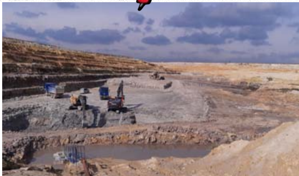
Foto: 2021 podzim, odtěžování nadložních písčitých jílu pro vytvoření odvodňovací retence na novém lomu.
