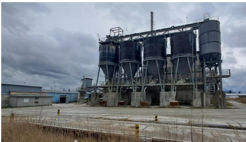
Obrázek 12. Sušení, mletí, třídění a mikromletí jílů ve Skalné
